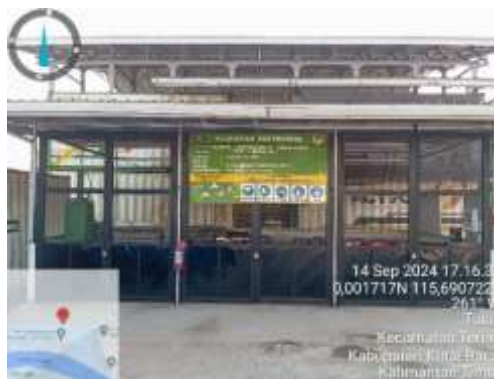
Gambar 1. TPS limbah B3 mempunyai atap Yang membuat terlindung dari sinar matahari dan hujan
