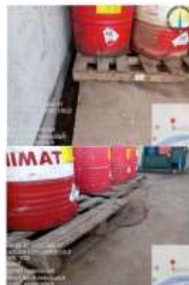
Gambar 2. Lantai TPS Limbah B3 PT. CEP yang kedap Air
