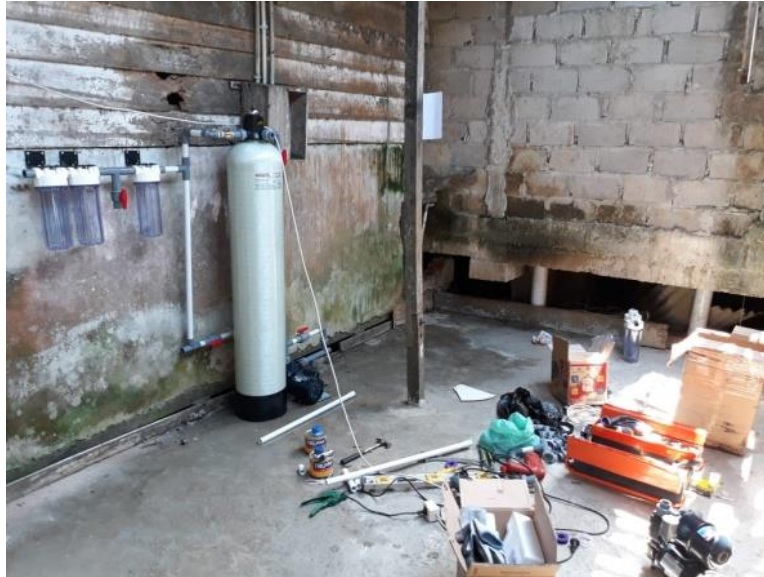
Gambar 2. Proses Perakitan Alat Backwash Air
