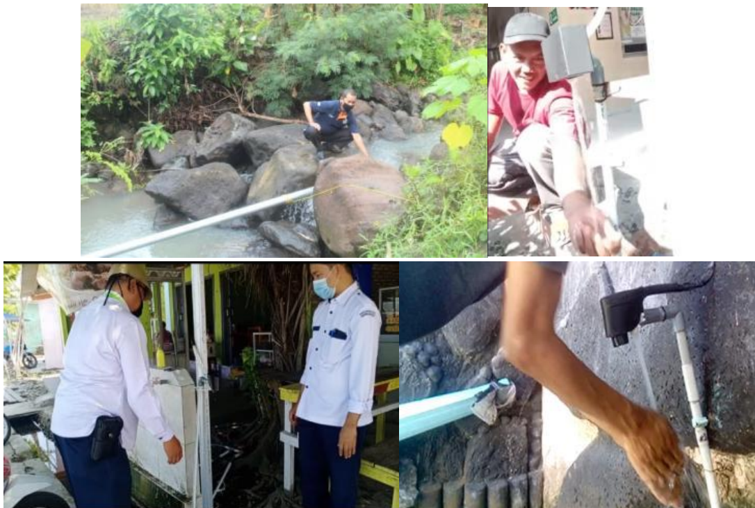
Gambar 2. Pemasangan alat cuci tangan
