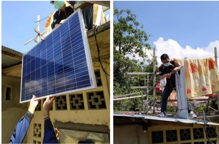
*Gambar 2. Pemasangan panel solar cell*
