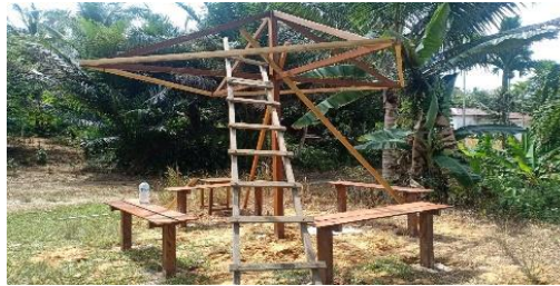
Gambar 5. Pemasangan kerangka atap solar station
