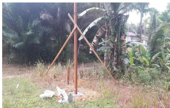
Gambar 4. Pemasangan tiang untuk solar station
