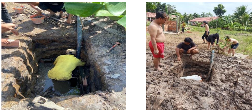
Gambar 5. Pemasangan dinding septic tank
