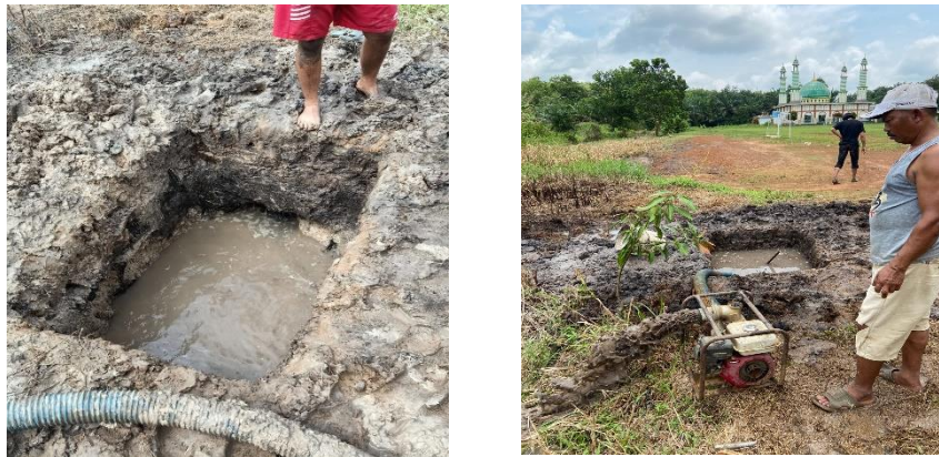
Gambar 4. Penggalian tanah dan pengeluaran air dalam septic tank
