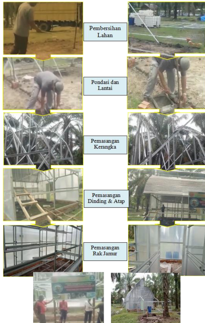
Gambar 3. Tahapan Pembangunan Kumbung Jamur
