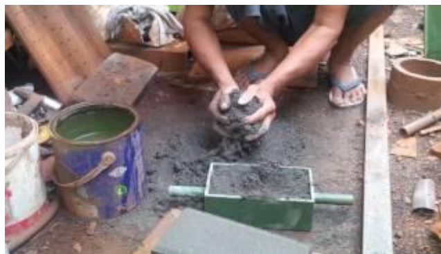
Gambar 9. Proses pencetakan dan pemampatan conblock
